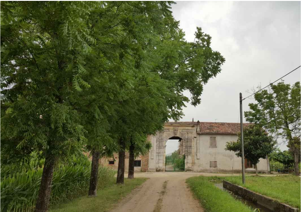
foto stato attuale
